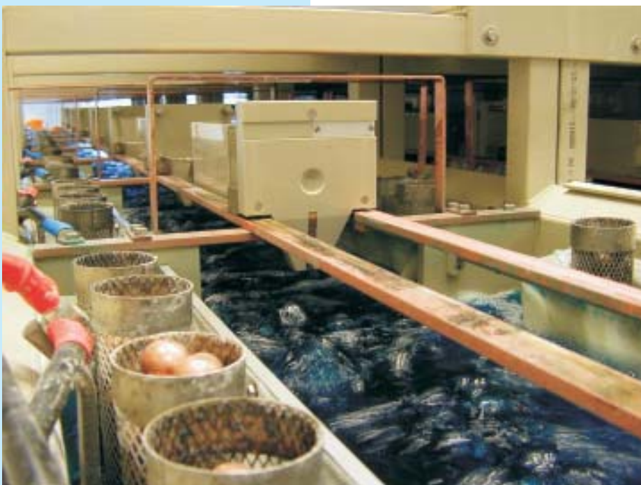
Blick in den geöffneten Galvano-Tunnel - die Platten werden quer durch die Galvanozellen geführt
